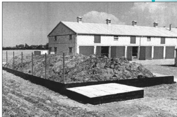
Fot 4. Płyta obornikowa ze zbiornikiem na tle obory
